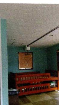
部屋中レールを引くので天井がはがされています。ドアの大きさも天井に合わせて大きくしました。工事の間、私と娘は、3階の部屋に避難して生活してました。部屋中のリフトは、"明電天井走行式リフト パートナー"です。ティンクルなごやに付いているリフトと同じなので、知っている方も多いのではないでしょうか。
